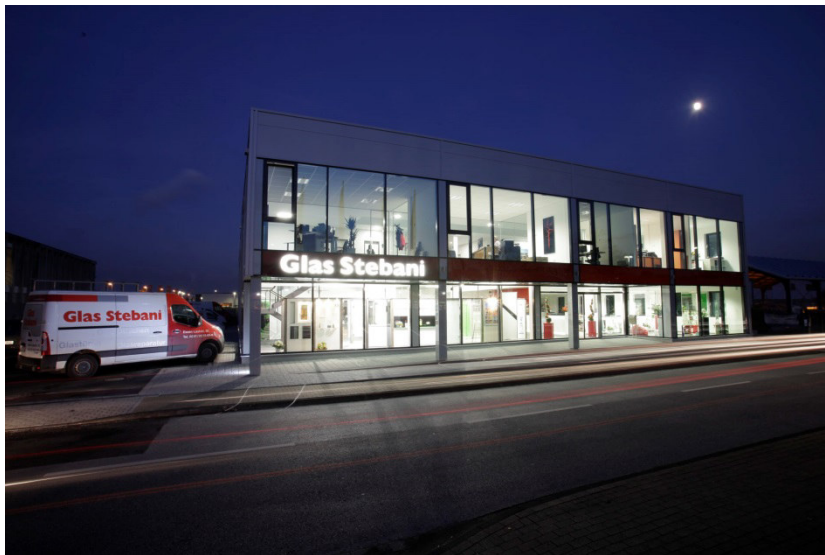
Der Neubau von Stebani Glas in Essen fungiert bei Tag und Nacht wie ein großes Schaufenster.
